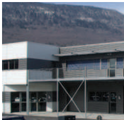
Bâtiment de bureaux Savoie Technolac
