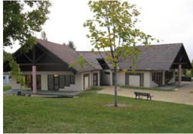
Ecole primaire de Montbonnot (Isère)
