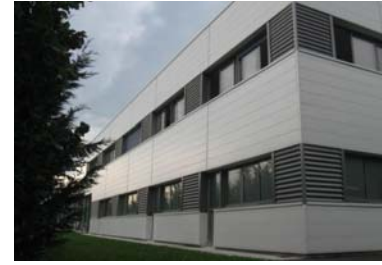
Bâtiment de bureaux Savoie Technolac
